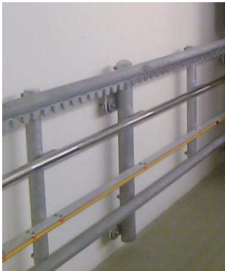
Fixation au mur
