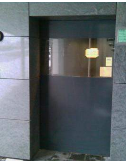
Station d'arrêt avec porte coulissante automatique
