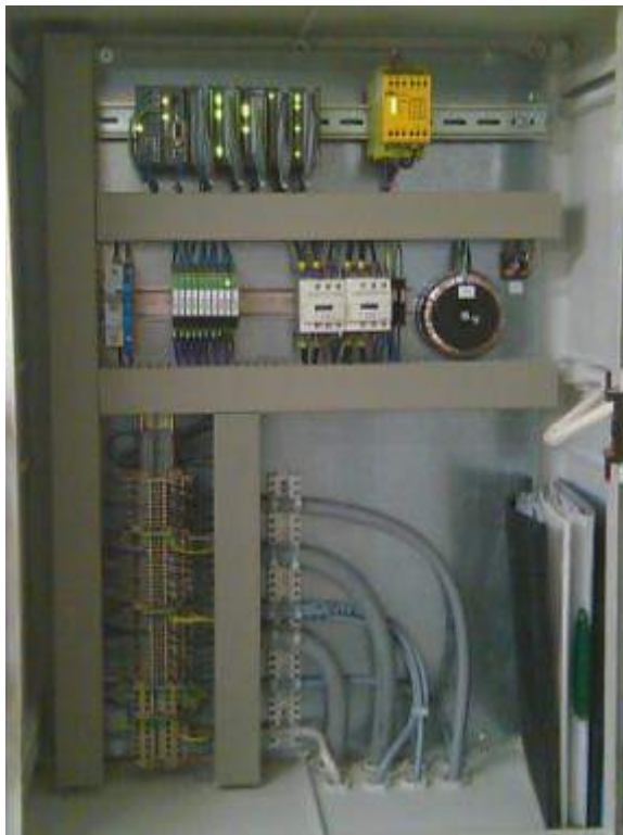
Boîtier de commande principal – vue intérieure
